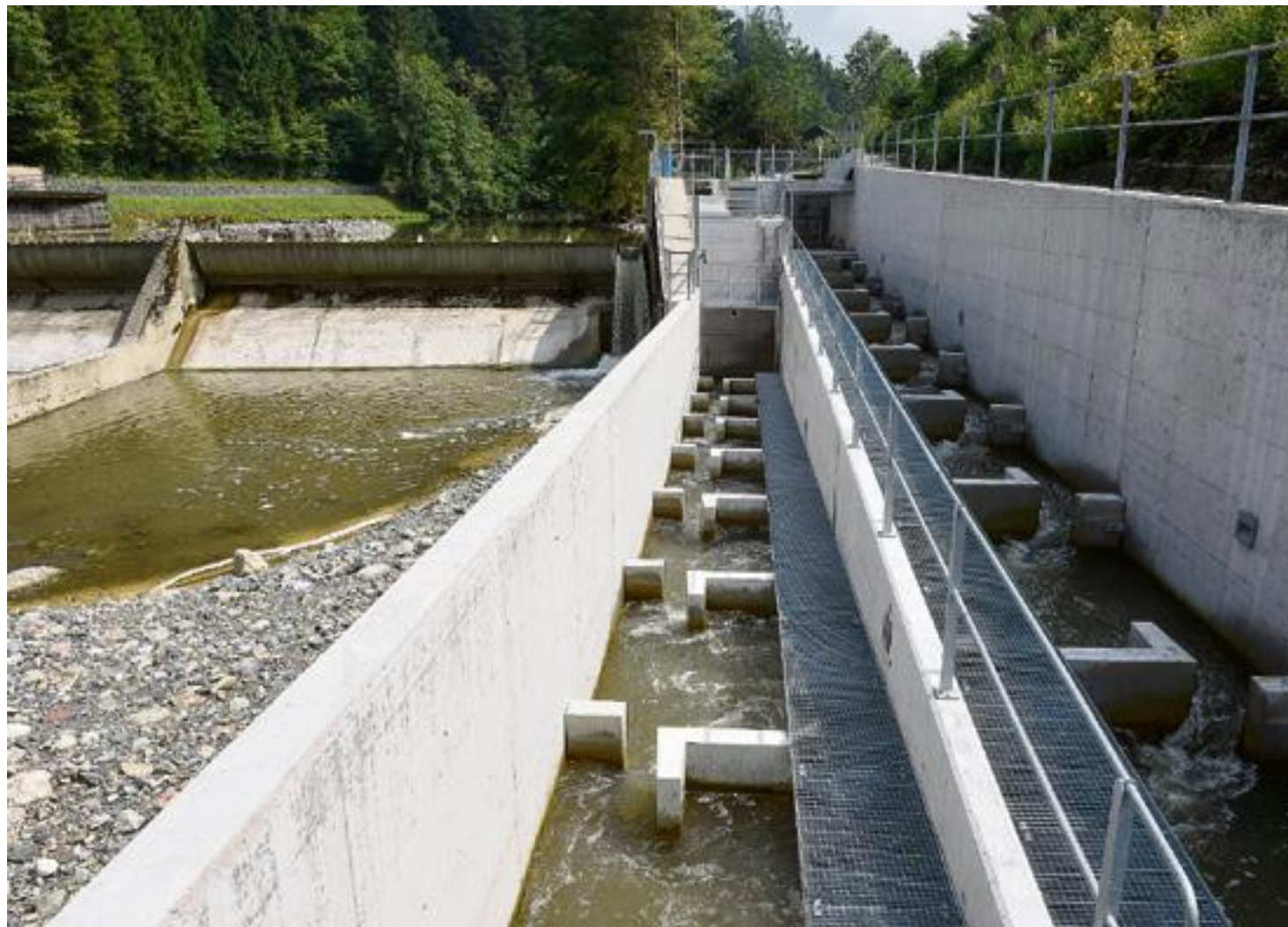
Schwimmen statt umkehren: Über die Fischtreppe gelangen die Fische am Wehr vorbei in ihre Laichgründe.
